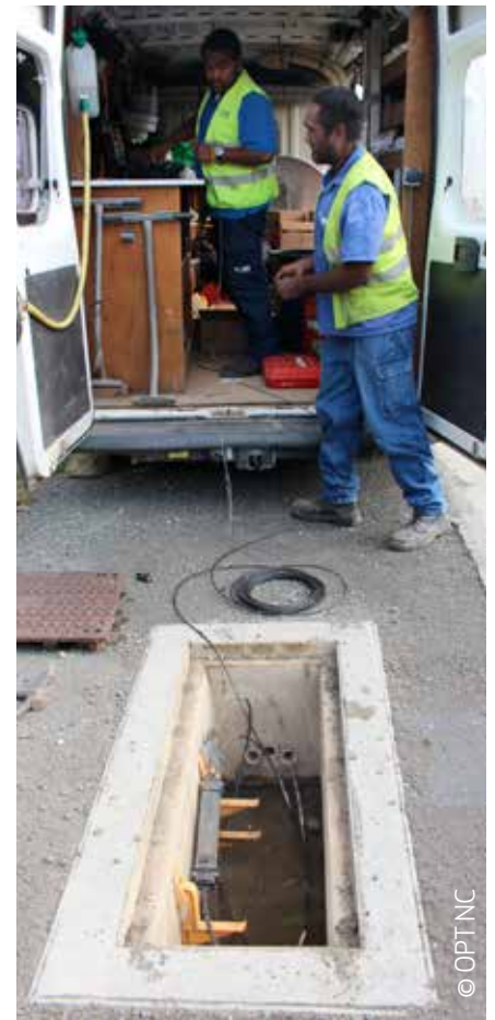
Les premiers travaux de déploiement de la fibre optique ont débuté mi 2015.
