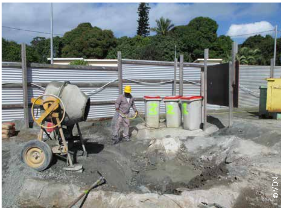
Sur ce chantier d'équipements publics de cœur de quartier (EPCQ) dont le maître d'ouvrage est la ville de Nouméa, on aperçoit au premier plan un bassin de décantation des laitances de béton. Derrière, trois bacs pour nettoyer les outils de peinture.
