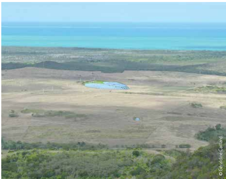
Vue de la ferme solaire Tiéa énergie située au sud de Pouembout.
